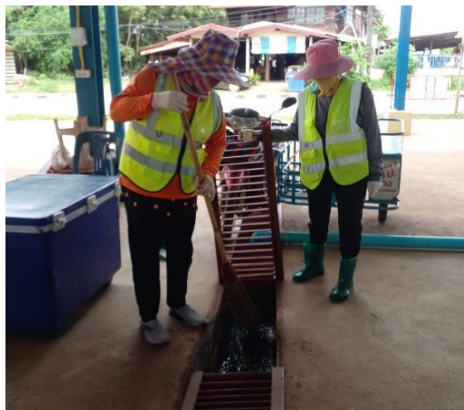
วางระบายนํ้าเสียเป็นชนิดรางเปิดและมีฝาปิดหรือตะแกรงเหล็กปิดสำหรับวางระบายนํ้ารอบตลาด สามารถเปิดทำความสะอาดได้ง่าย
