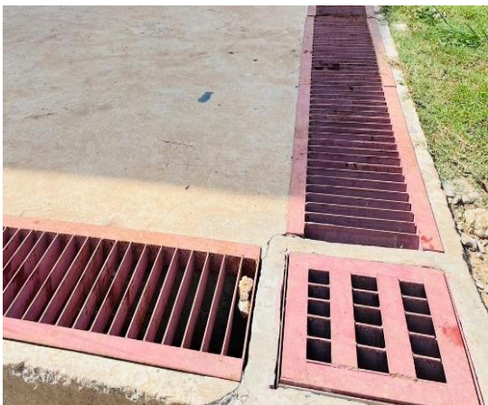
วางระบายนํ้าเสียเป็นชนิดรางเปิดและมีฝาปิดหรือตะแกรงเหล็กปิดสำหรับวางระบายนํ้ารอบตลาด สามารถเปิดทำความสะอาดได้ง่าย
